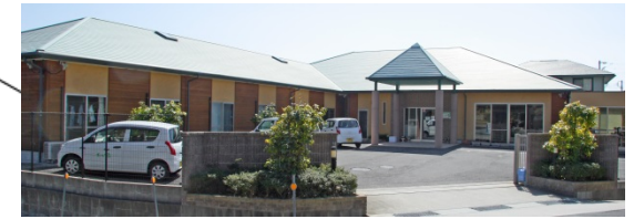
介護付有料老人ホーム わが家 30床 (三重県津市)
