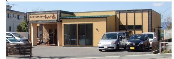
デイサービスセンター わが家 (三重県津市)
